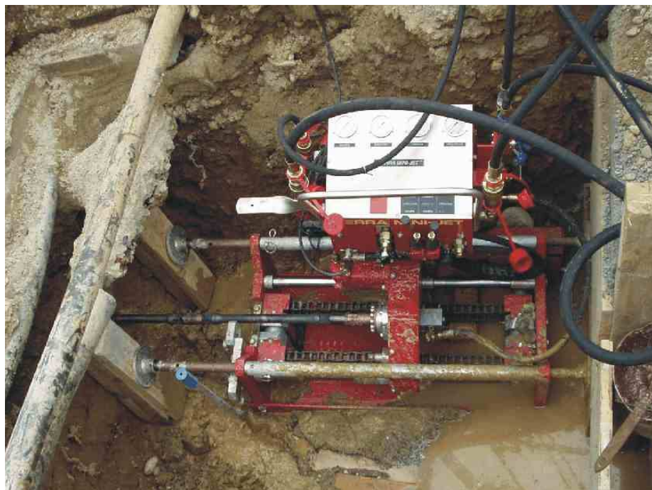
TERRA MINI-JET в стартовом котловане во время пилотного бурения.
