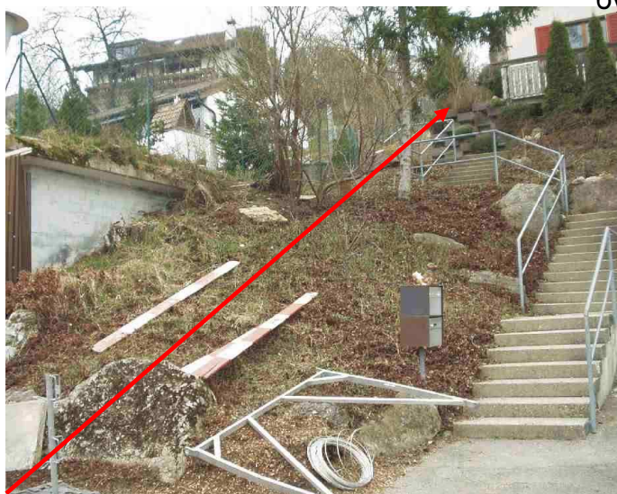
Траектория бурения по направлению вверх. Уклон составляет приблизительно 20 %.
