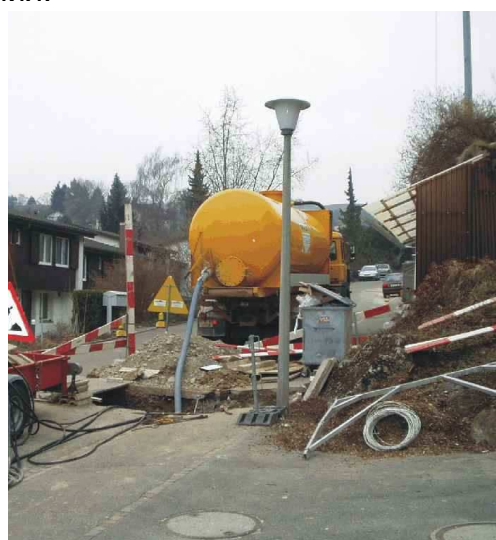
Бентонит и частицы грунта из буровой скважины через шланг откачиваются из стартового котлована.
