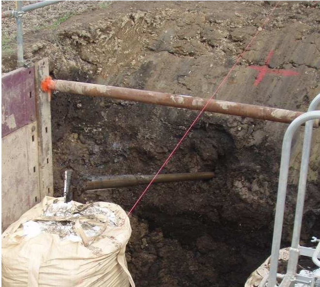
Буровая головка с точностью достигла приемного котлована.
