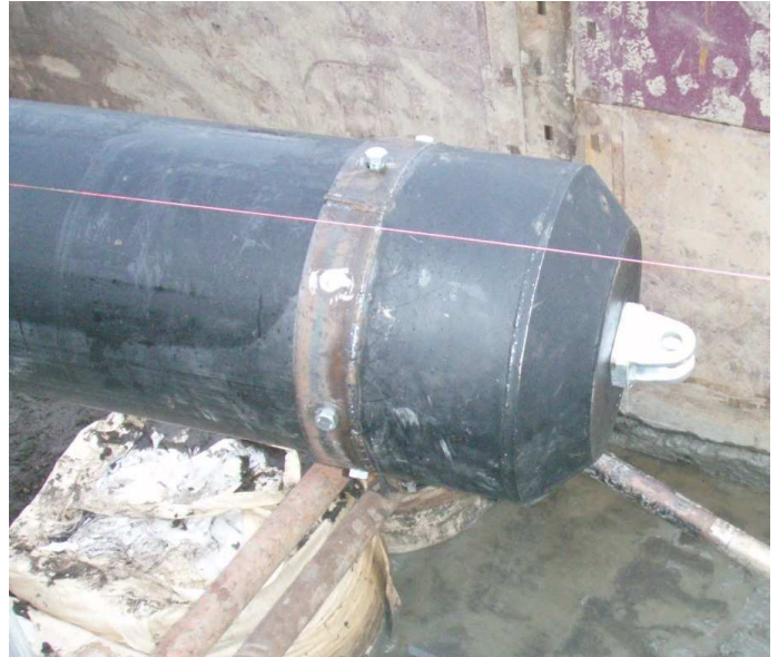
Тяговая головка, смонтированная с ПЭ трубой Ø 560 мм.
