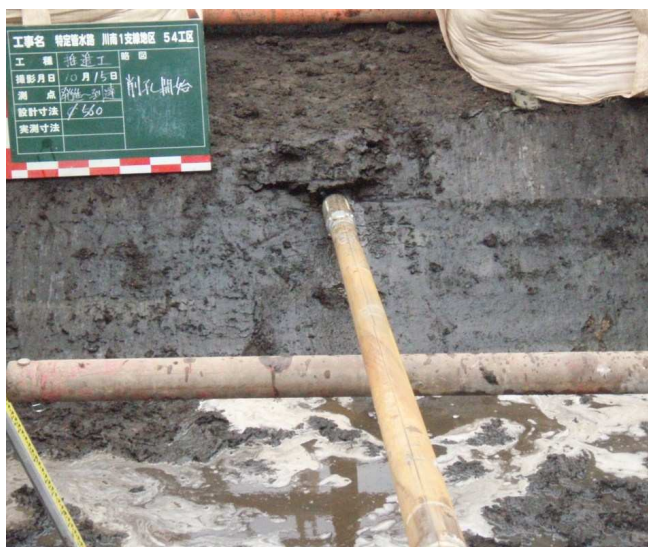
Начало шестидесятиметрового пилотного бурения.
