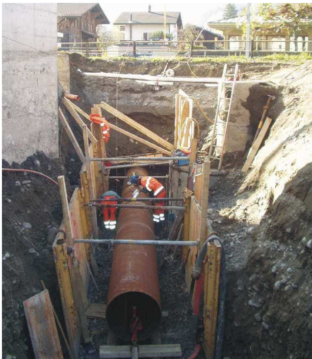
Установка стальной трубы Ø 800 мм в стартовом котловане.
