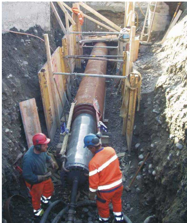
TERRA-RAMMEN TR 565 соединяется со стальной трубой при помощи натяжных ремней. Работы по забивке можно начинать.
