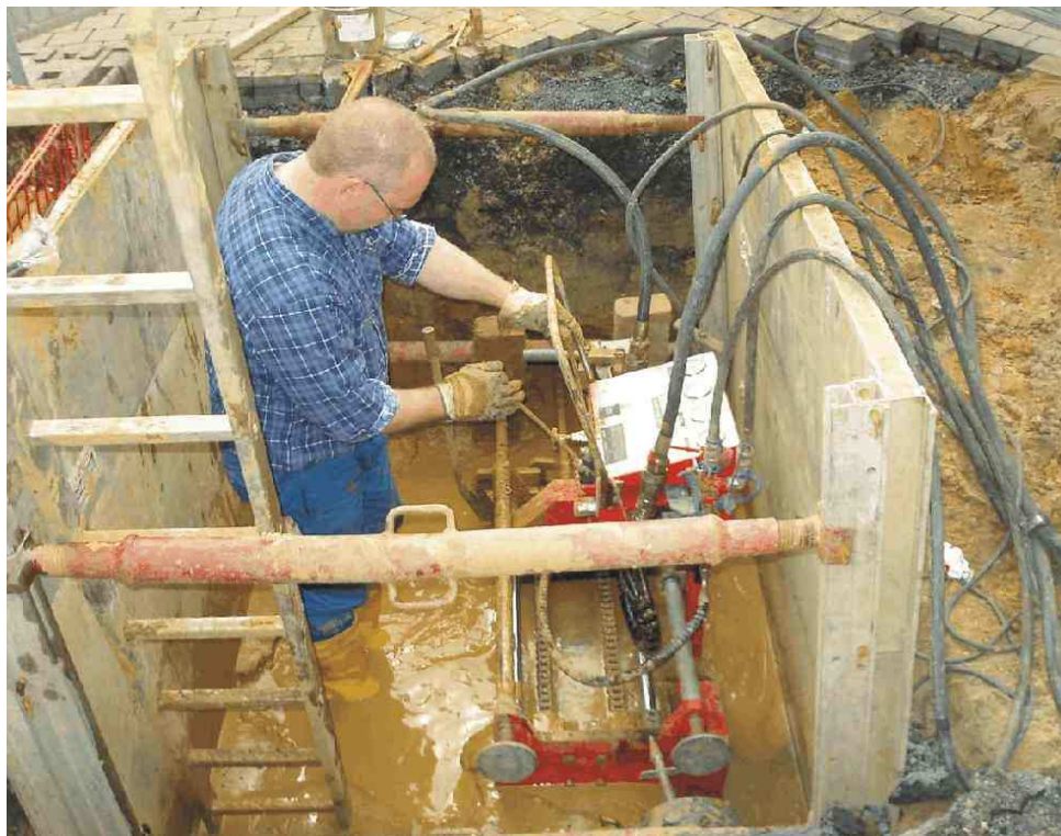
TERRA MINI-JET в стартовом котловане во время пилотного бурения.
