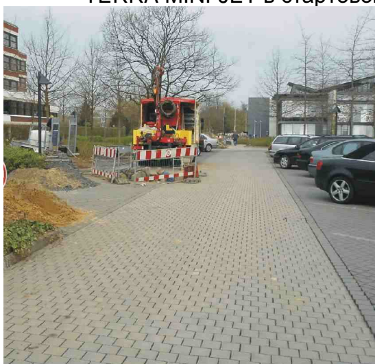
TERRA MINI-JET в стартовом котловане во время пилотного бурения.
