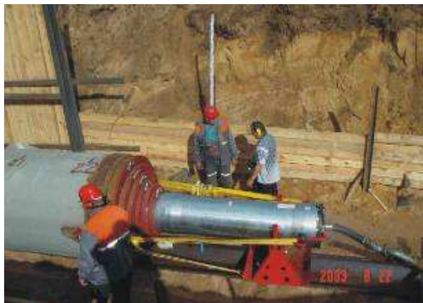
Фото сверху: TERRA-RAMMEN TR 565 забивает трубу \varnothing 1400 мм.
