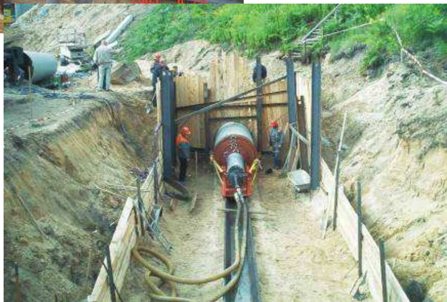
Фото сверху и справа: Труба \varnothing 1400 мм забита на расстояние 22 м менее чем за 3 часа.
