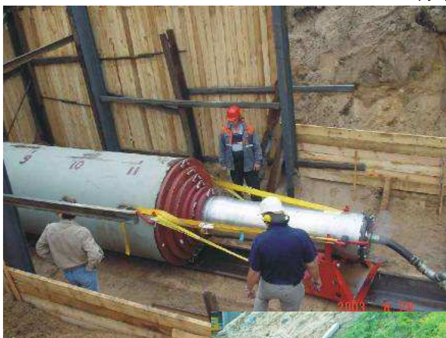
Фото сверху: TERRA-RAMMEN TR 565 забивает трубу \varnothing 1400 мм.
