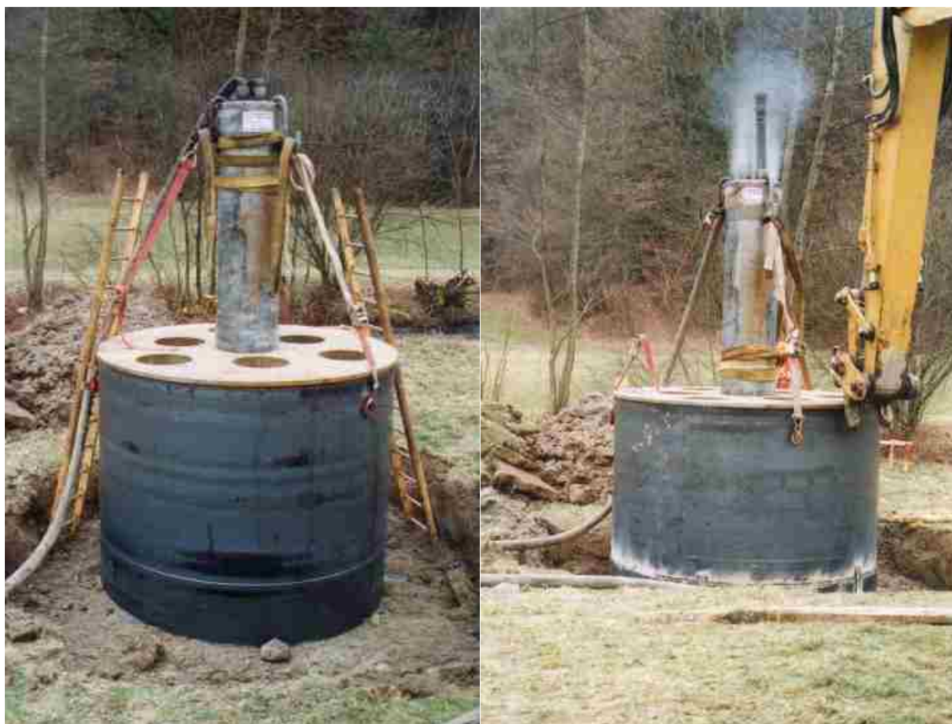
TERRA-RAMMEN TR 565 забивает стальную трубу Ø 2500 мм. Сила удара составляет 2200 тонн.
