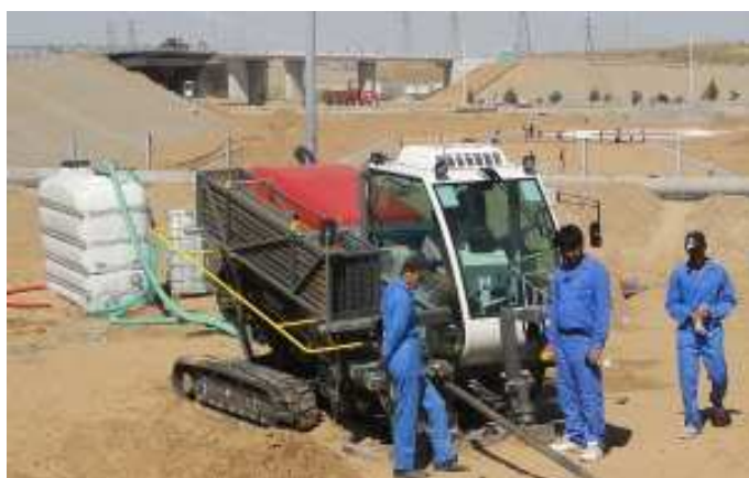
TERRA-JET 8522 S во время пилотного бурения.
