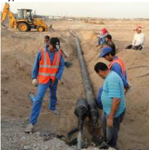
Стальная труба внешним \varnothing 324 мм соединяется с расширителем \varnothing 420 мм
