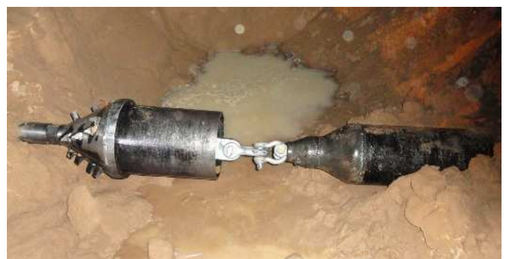
Стальная труба внешним \varnothing 324 мм протянута на противоположную сторону дороги на расстояние 65 м.
