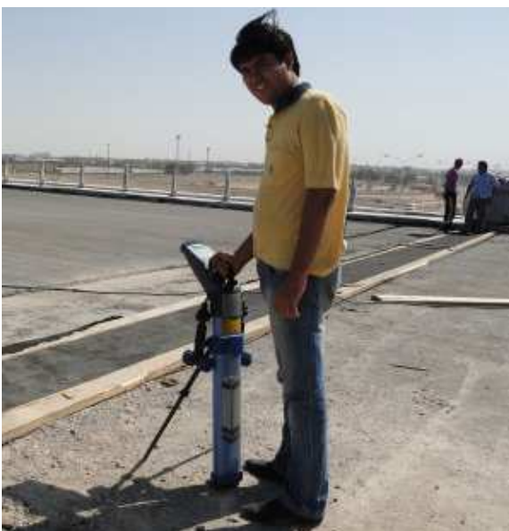
Определение местоположения буровой головки во время пилотного бурения.
