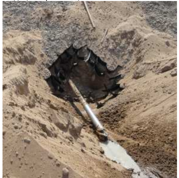
Буровая головка показывается на противоположной стороне дороги.
