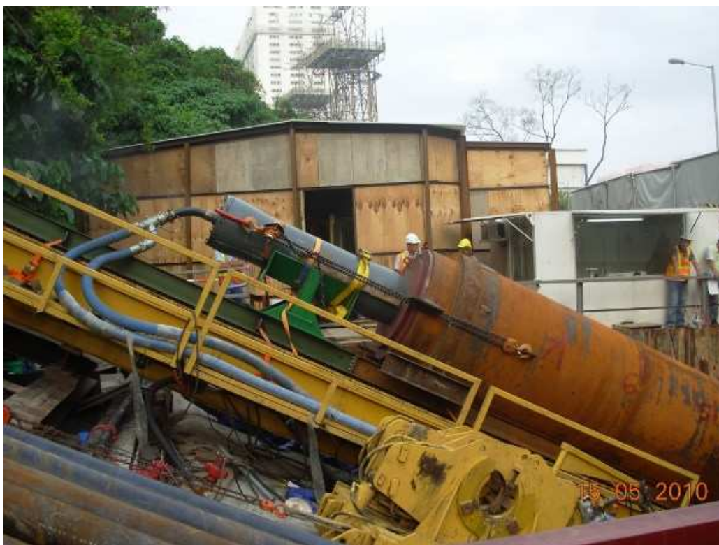
TERRA-RAMMEN TR 565 во время забивки трубы внешним ∅ 1400 мм.
