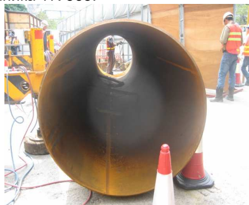
Стальная труба ∅ 1400 мм.
