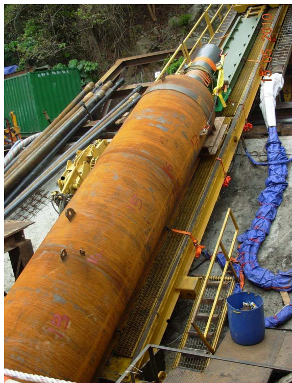
TERRA-RAMMEN TR 565 во время забивки трубы.
