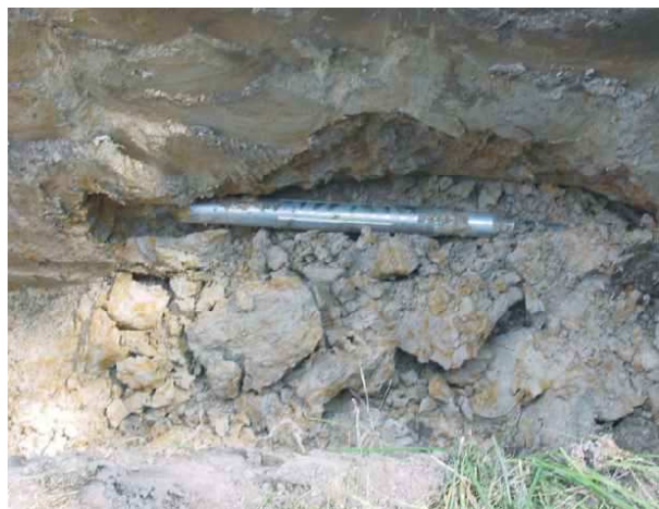
Фото внизу слева: Расширитель и новая ПЭ труба показали в стартовом котловане. Теперь они будут затянуты в лафет и демонтированы.
