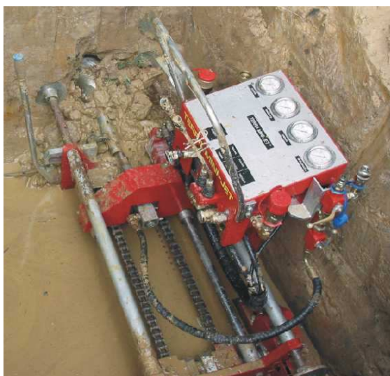
Фото внизу справа: Новая ПЭ труба внешним Ø 90 мм успешно затянута.
