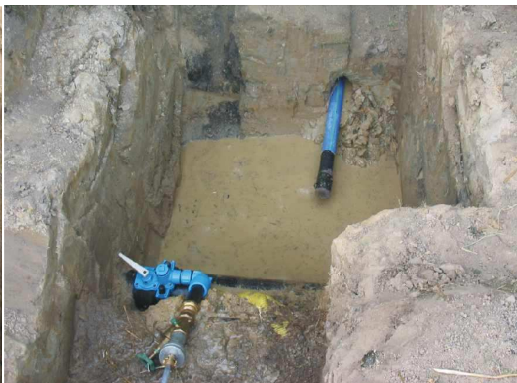
Фото внизу справа: Новая ПЭ труба внешним Ø 90 мм успешно затянута.
