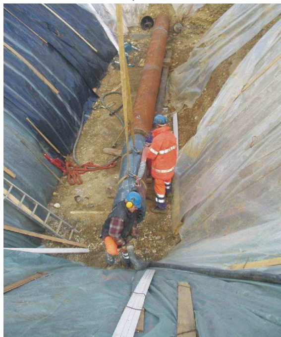
Новая секция трубы длиной 6 м устанавливается и приваривается прямо в рабочем котловане. Пробойник TERRA-RAMMEN TR 565 надежно присоединен к трубе натяжными ремнями.
