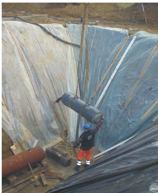
TERRA-RAMMEN TR 565 опускается в рабочий котлован.
