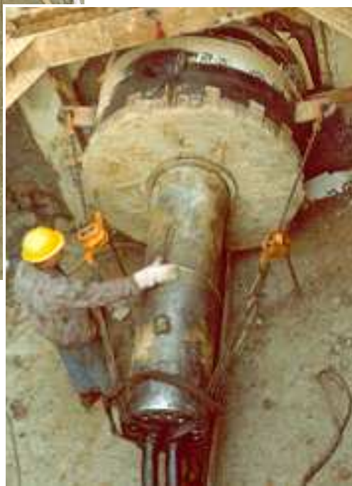
Фото справа: Пробойник TERRA-RAMMEN TR 565 забивает стальную трубу внешним Ø 1500 мм со средней скоростью 2 - 4 м/ч.
