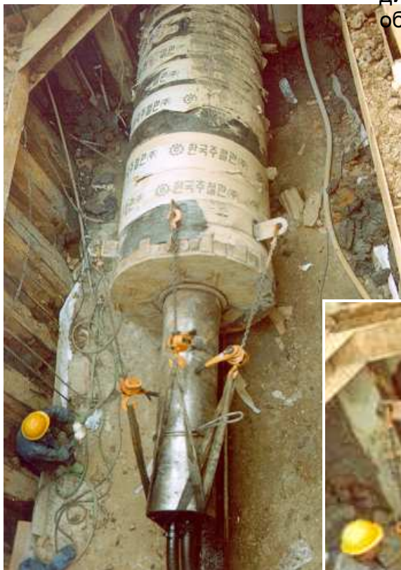
Фото справа: Пробойник TERRA-RAMMEN TR 565 забивает стальную трубу внешним Ø 1500 мм со средней скоростью 2 - 4 м/ч.
