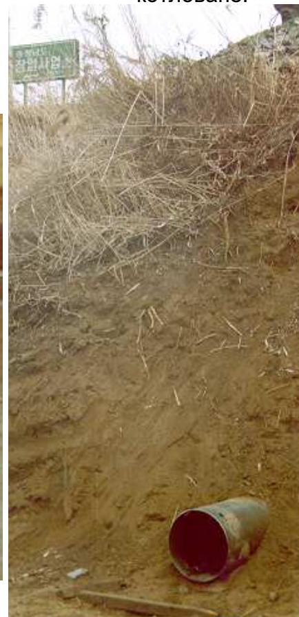
Фото внизу: Через 25 м труба диаметром Ø 1500 мм появляется в приемном котловане.
