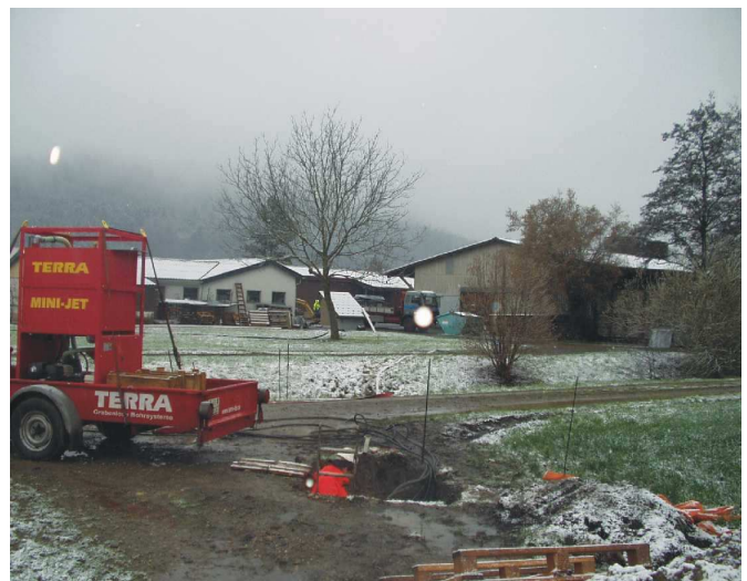
Установка TERRA MINI-JET в стартовом котловане.
