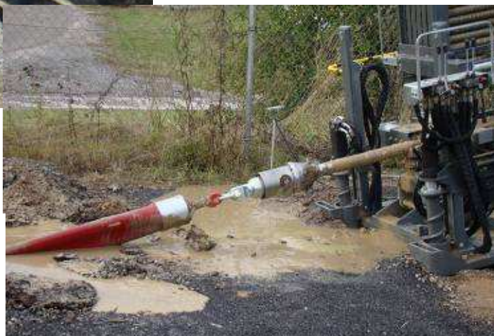
Труба ПЭ длиной 80 м \varnothing 160 мм, присоединенная к тяговой головке.
