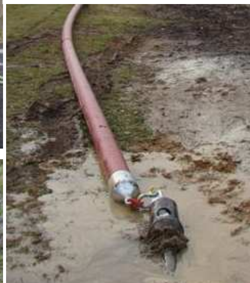
Труба ПЭ длиной 80 м \varnothing 160 мм, присоединенная к тяговой головке.
