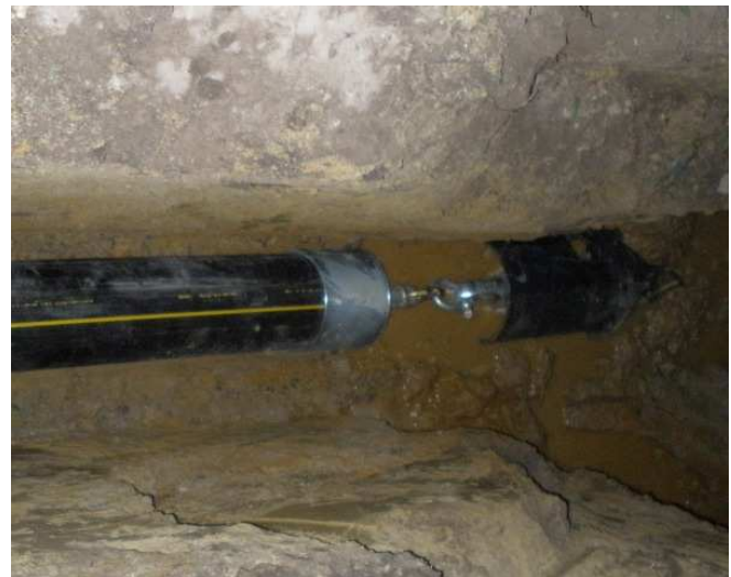
Начало расширения и протяжки новой ПЭ трубы внешним \varnothing 200 мм.
