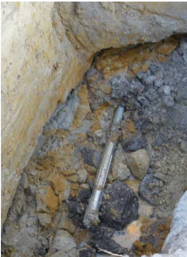
↑ Буровая головка достигла приемного котлована.
