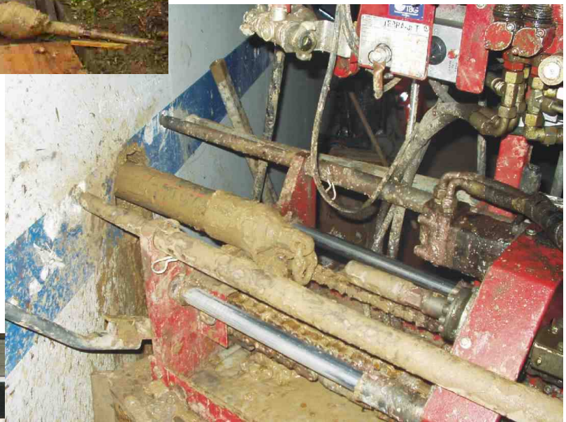
Фото справа: Через 2 часа ПЭ была успешно затянута.
