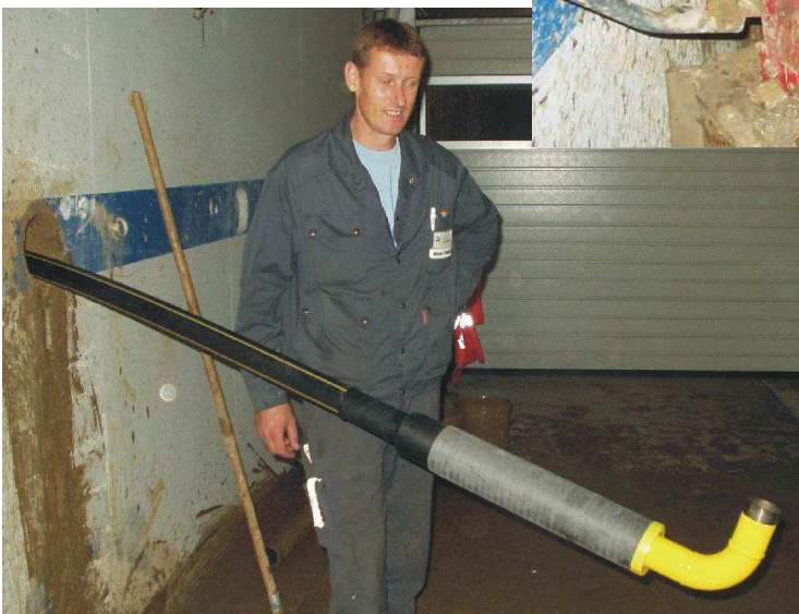
Фото слева: ПЭ труба для газоснабжения внешним \varnothing 63 мм сразу же затянута в защитную трубу.
