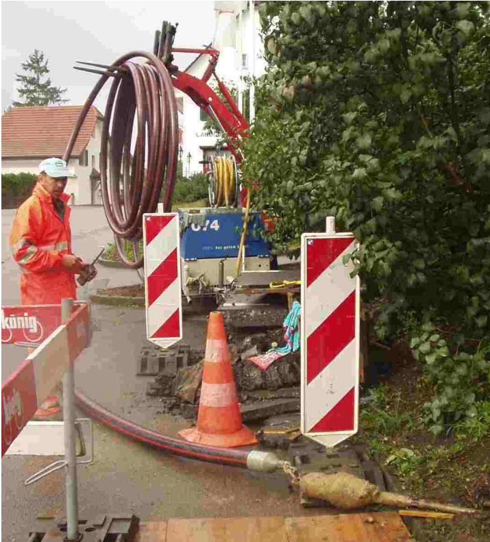
Фото слева: Протяжка ПЭ трубы внешним \varnothing 92 мм с расширителем \varnothing 160 мм.
