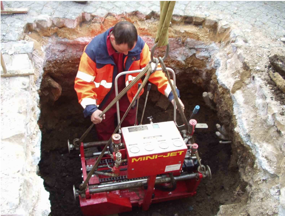
Фото слева: устанавливается в стартовый котлован.
