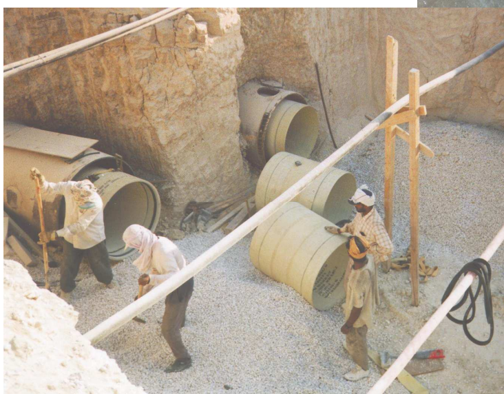
Стеклопластиковые трубы Ø 900 были затянуты в стальные и очищены от остатков грунта.
