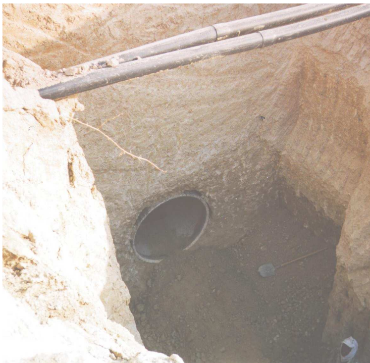
Стальная труба Ø 1200 мм в приемном котловане через 25 м.
