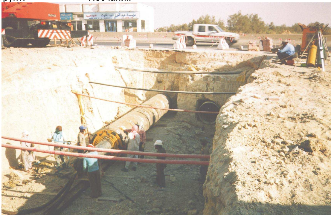
Пневмопробойник TERRA-RAMMEN TR 565 во время забивки трубы. Первая труба забита полностью.
