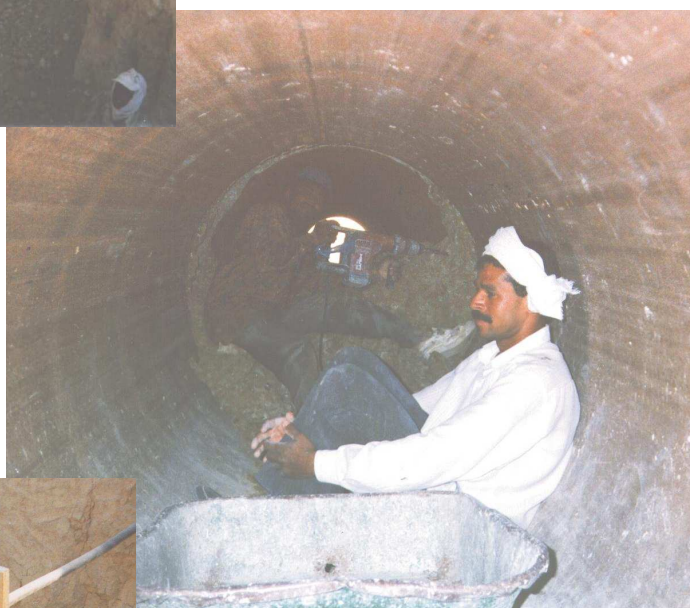
Стеклопластиковые трубы Ø 900 были затянуты в стальные и очищены от остатков грунта.
