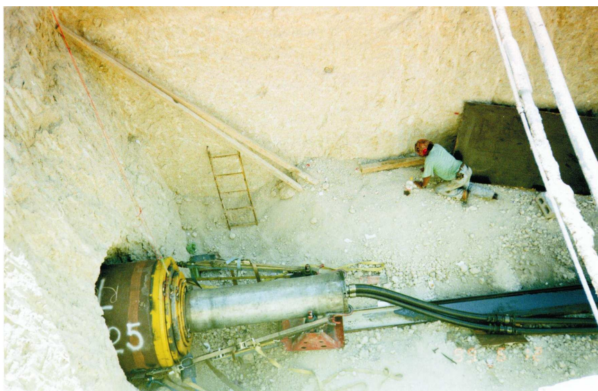
Пневмопробойник TERRA-RAMMEN TR 565 во время забивки трубы. Первая труба забита полностью.
