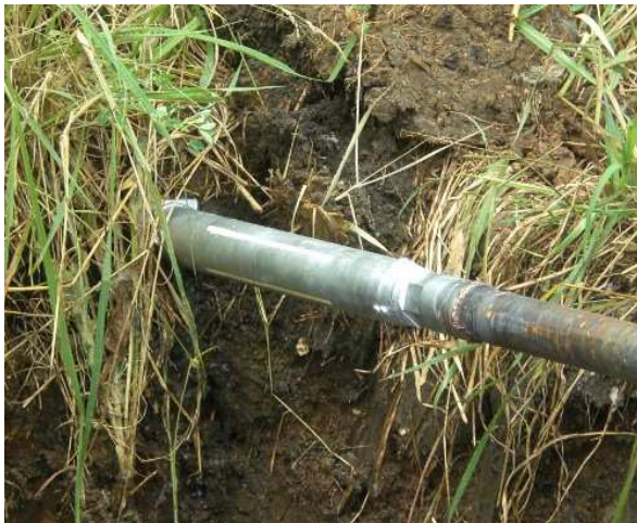
Начало пилотного бурения на расстоянии 140 м.
