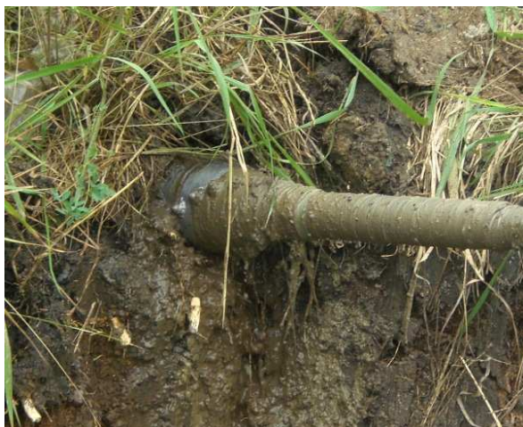
Завершение первого промежуточного расширения.
